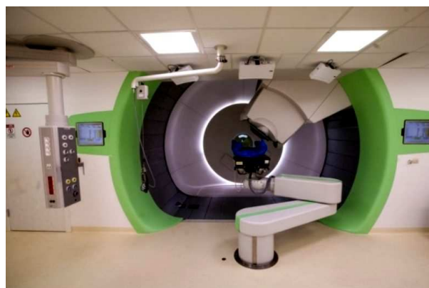
Rys. 5. Cyklotron Proteus C-235 oraz jedno z dwóch stanowisk gantry w Centrum Terapii Protonowej w Bronowicach. Stanowiska te powinny rozpocząć terapie w IV. kwartale 2015 r.
