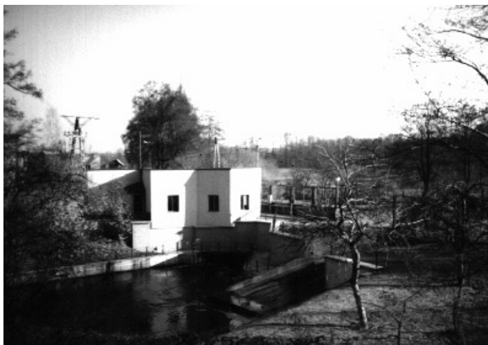
Mała elektrownia wodna – MEW w Wadągu (widok ogólny), fot. autor
