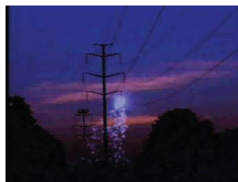
Awaria sieci elektrycznej spowodowana burzą magnetyczną
