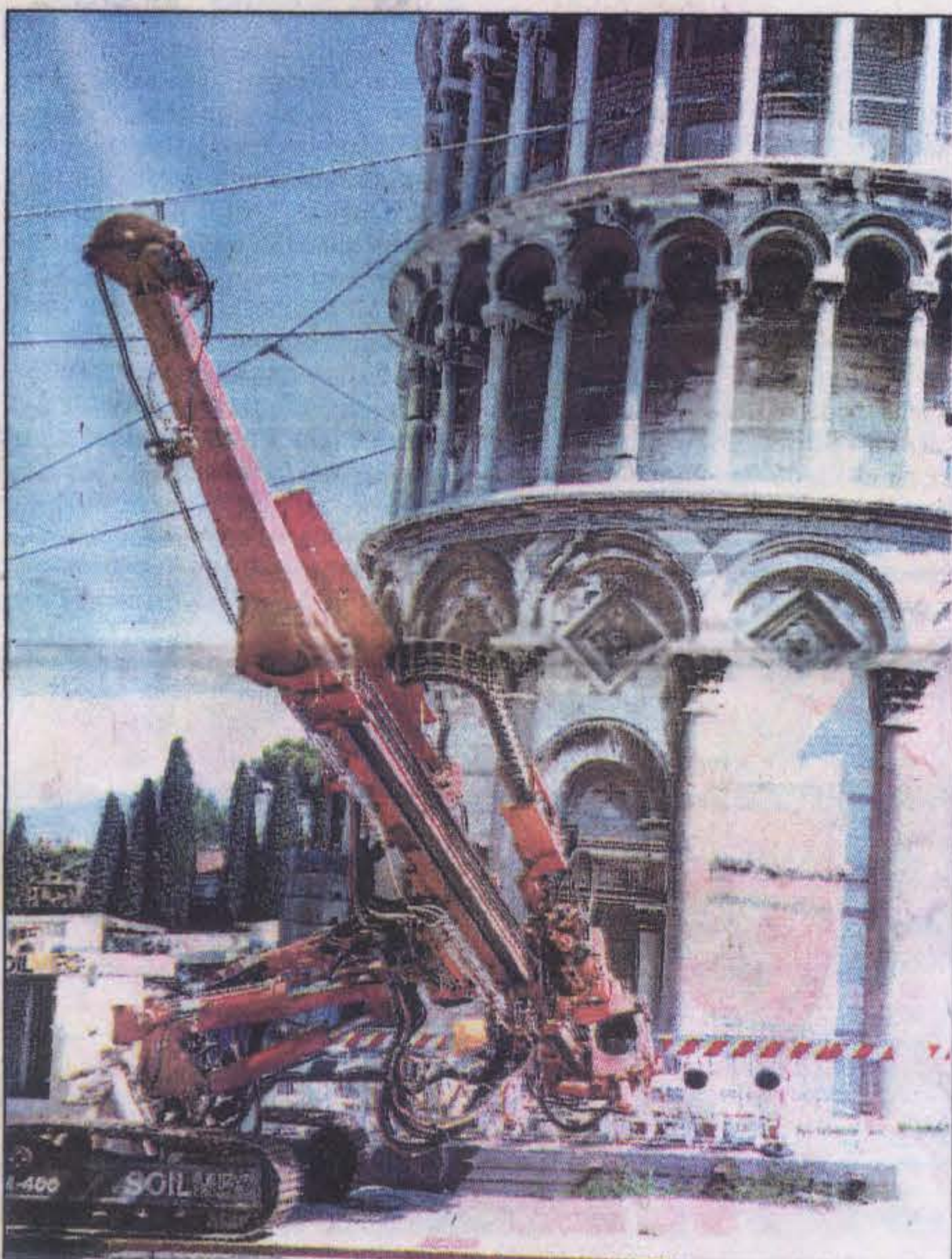
Prace nad prostowaniem Wieży: maszyna do ekstrakcji gruntu, za nią szare ołowiane bloki na fundamentach Wieży, na prawo na dole - dwie rury do ekstrakcji.
